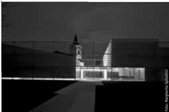
Pfarrzentrum Podersdorf, Architektur lichtblau.wagner, Wien. Der Außenbereich wird durch zwei Glaswände gefasst, auf denen Texte aus dem Gemeindeleben erscheinen.
